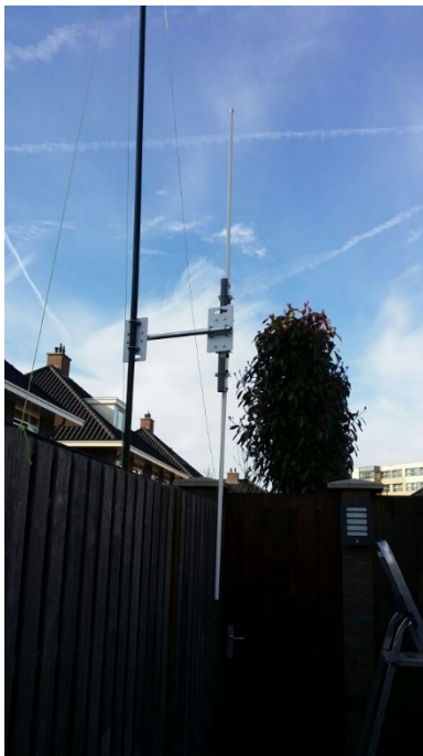
Figuur 1. Twee dualbanders in 1 mast (2015)
